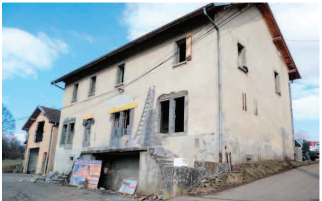
Fruitière de Pouilly, en cours de restauration. Photo A. Blanc 2012
