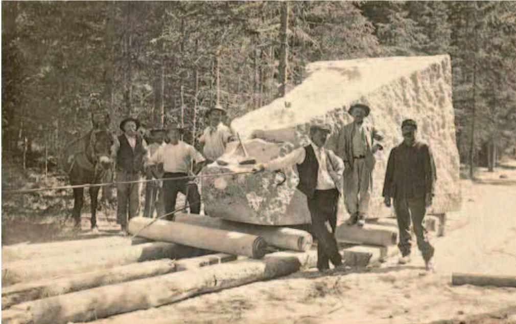
*Méthode utilisée par les tailleurs de granit de Combloux pour transporter leurs blocs*
