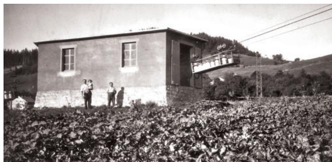
La cabane de la Mouille. A droite, en arrière-plan le câble avec la benne arrivant de Plaine-Joux, au premier plan, le câble avec la benne arrivant de Granges-Pagnoud. A gauche, le câble avec la benne pour la fruitière de Bogève.
