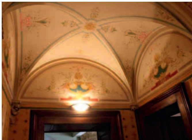
Dans le bâtiment actuel, les voûtes de la chapelle du XVII e ont été conservées.
