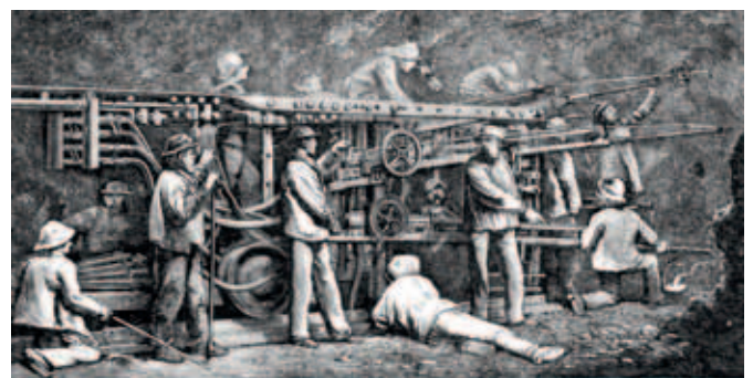
La perforatrice Sommeiller en action (Nouvelles conquêtes de la science, p.175).
