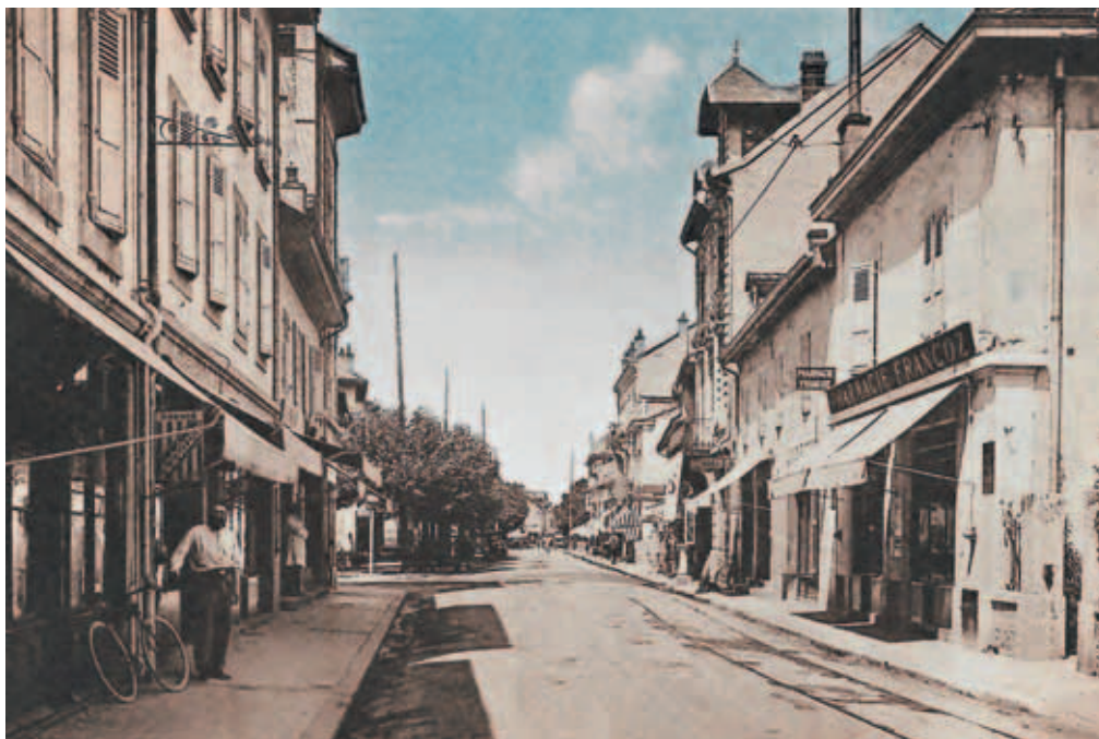
La rue Centrale d'Annemasse, aujourd'hui rue du Commerce, vers 1925.
