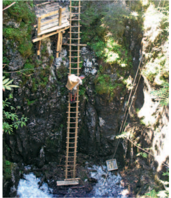
Vue plongeante sur une tanne avec son échelle, à droite le système de remontée par plateau-catelle.
