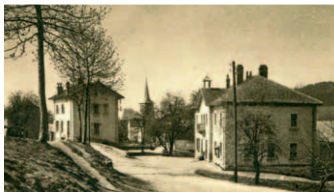
Les écoles de Bogève : à gauche l'école des garçons, à droite l'école des filles-mairie.
