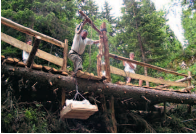
Récupération de la neige par système plateau-catelle.
